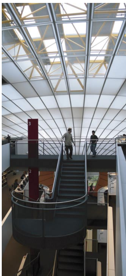
Průhled vnitřní membránou na nosnou konstrukci pláště a vnější hliníkové nebo zasklené panely. Foto Transat architekti
